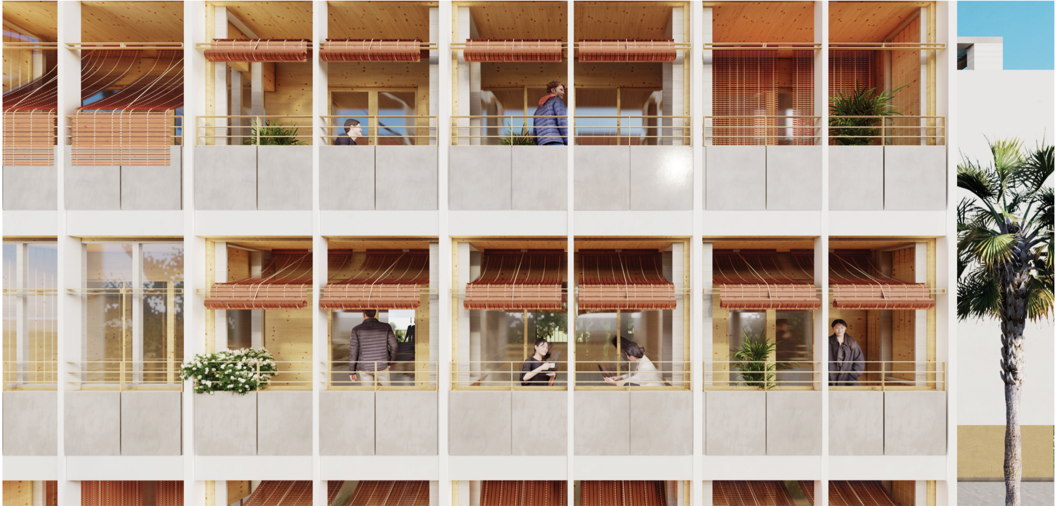
Imagen de la fachada exterior de los edificios
