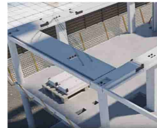
Colocación losas alveolares
