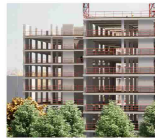
Vista general estructura
