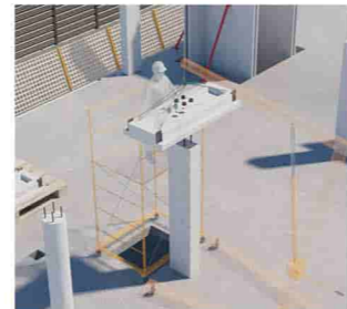
Colocación placa de anclaje
