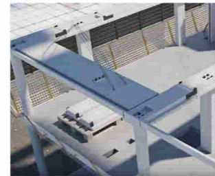
Colocación losas alveolares
