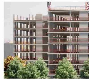
Vista general estructura
