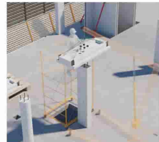
Colocación placa de anclaje
