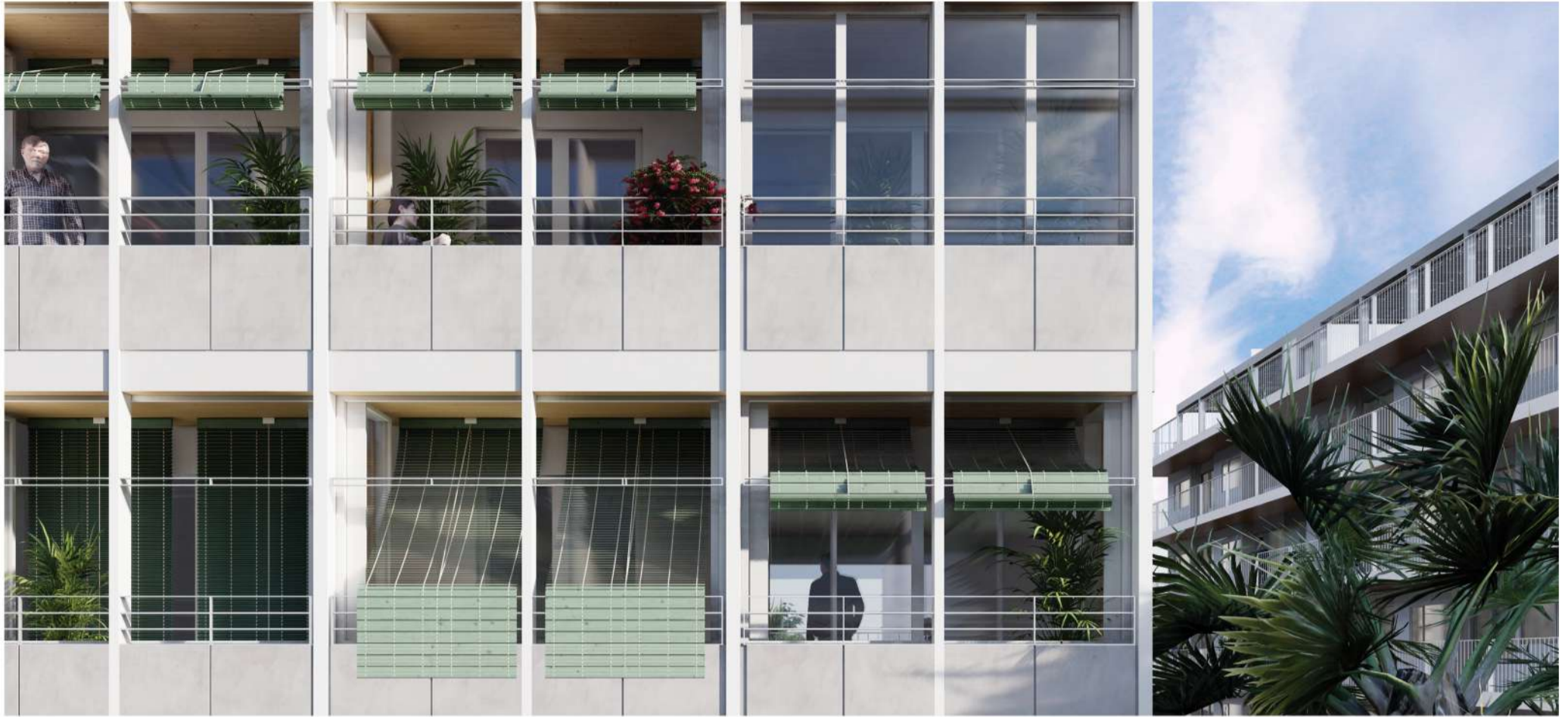
Imagen de la fachada exterior de los edificios
