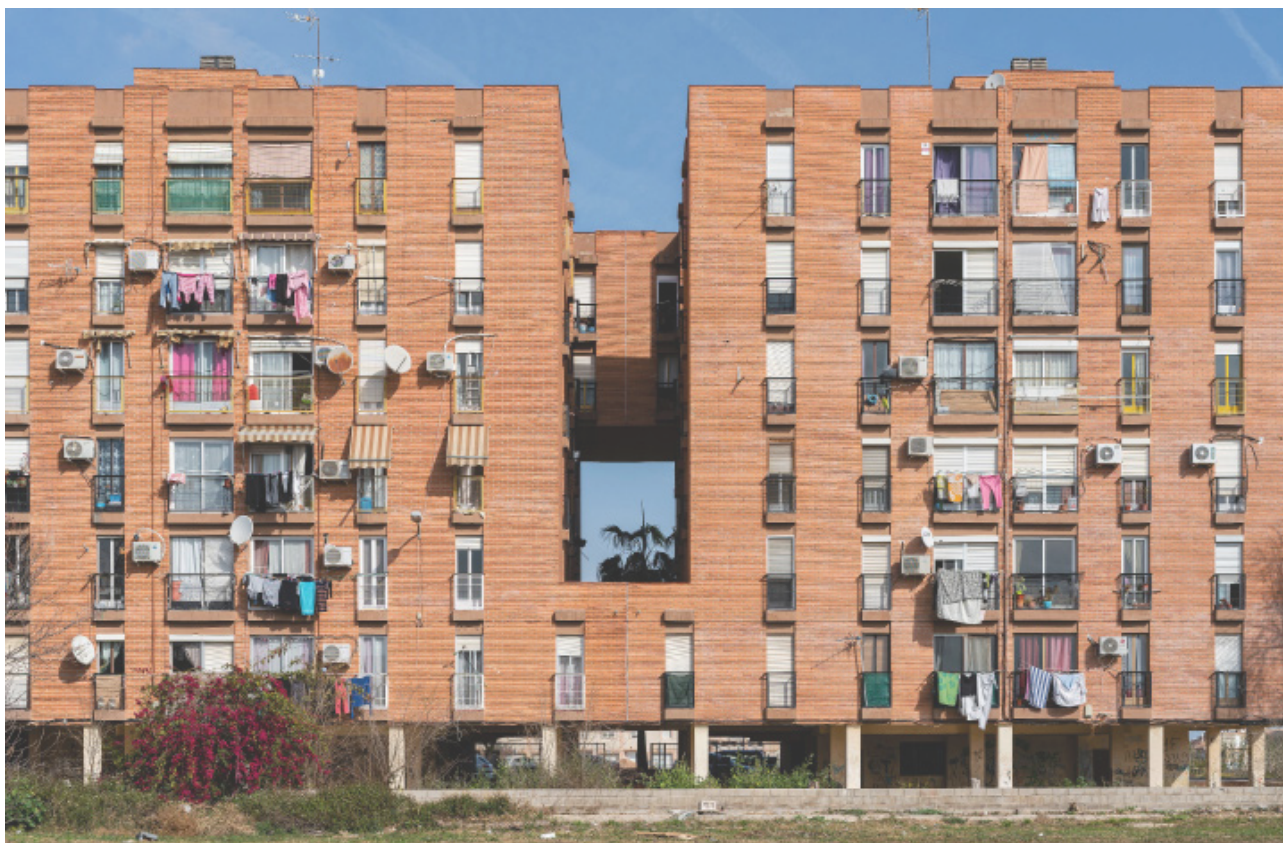
Viviendas en Alfafar, Valencia
