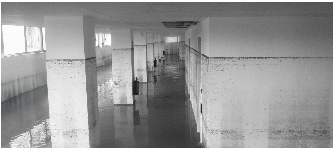
Sótano de un edificio de viviendas públicas en Alfafar, Valencia
