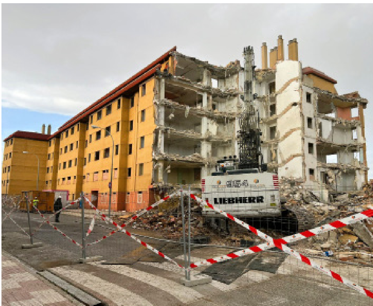
Demolición en Alberic, Valencia
